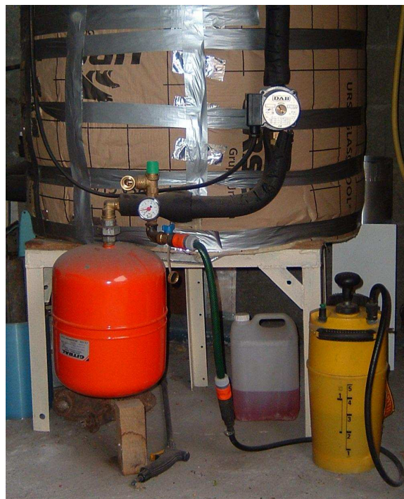
Le système de remplissage et de mise en pression du circuit solaire.
