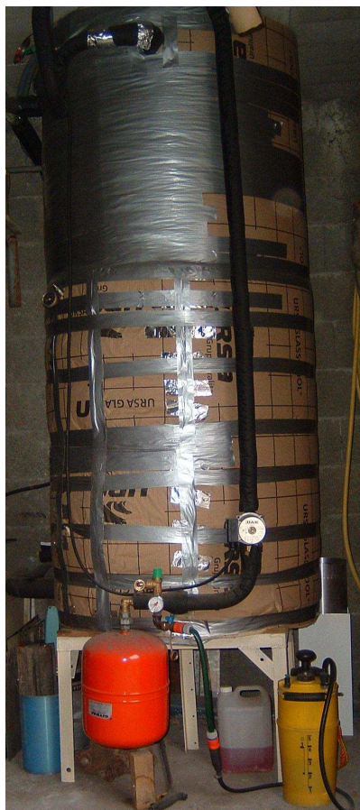
La cuve en position
