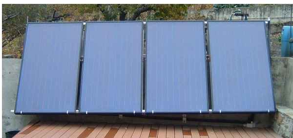
4 panneaux orientés sud,-15° Inclinés à 60°
